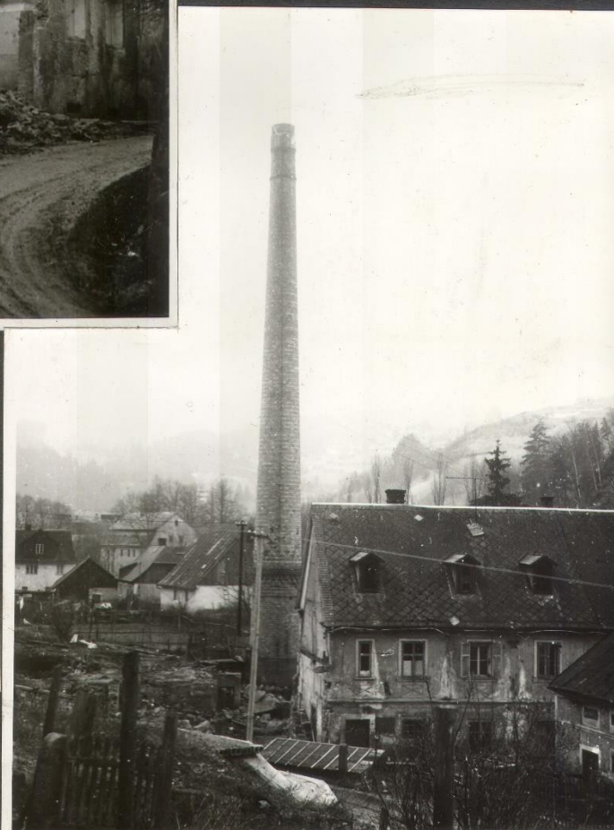
Komín s bývalou budovou elektrárny. Komín stržen odstřelem v únoru 1966.
