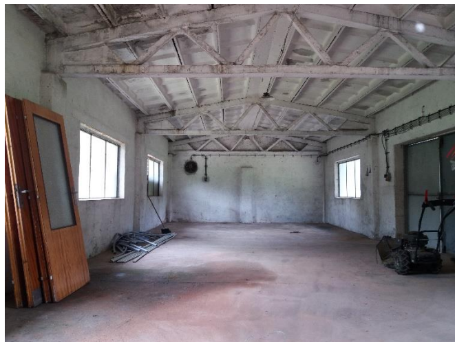
Skladová hala před adaptací
