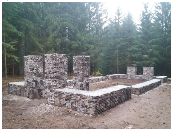
Po realizaci, říjen 2020
