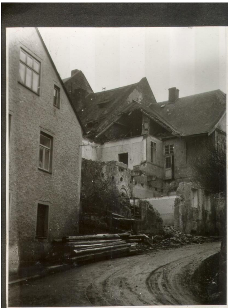
Starý dům č. 33 v Poštovní ulici při bourání.
