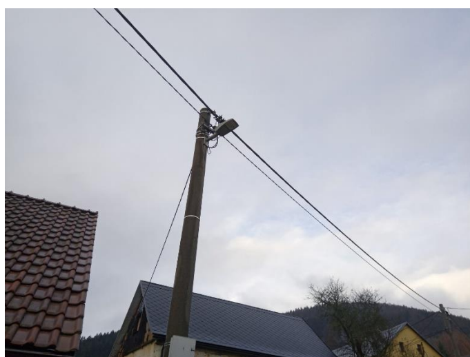
Výměna svítidel veřejného osvětlení v místních částech Vodná a Krásný Jez
