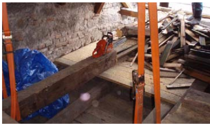
V současnosti se odstraňuje napadené dřevo na podlaze půdy radnice
