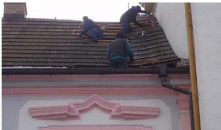
Oprava radnice napadené dřevomorkou pokračuje i v letošním roce 2009
