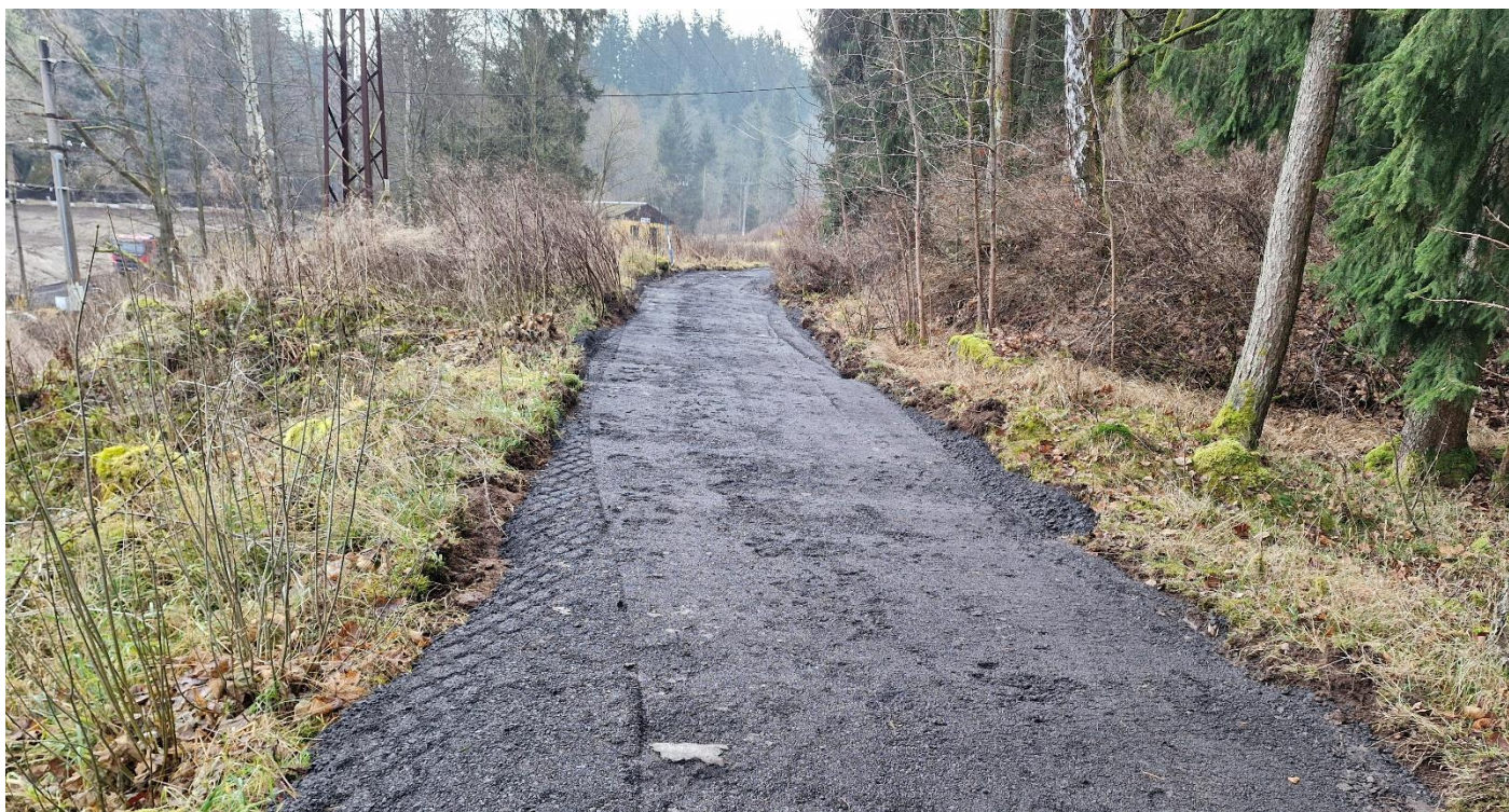
Terénní úpravy v areálu fotbalového hřiště a přilehlého okolí
