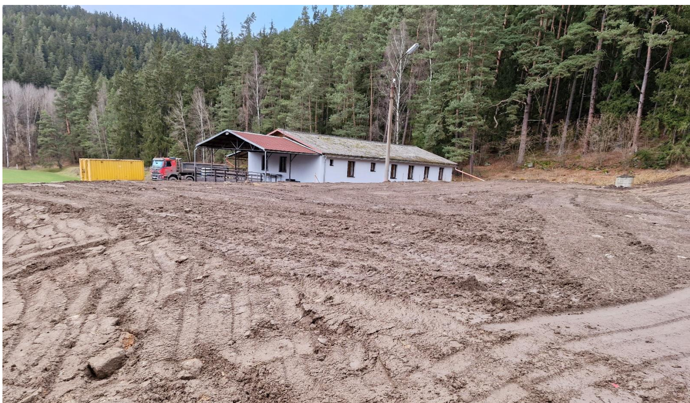
Terénní úpravy v areálu fotbalového hřiště a přilehlého okolí
