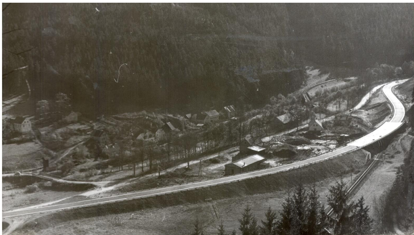
Silniční nadjezd nad železniční tratí ve Vodňe, dokončený v r.1966.
