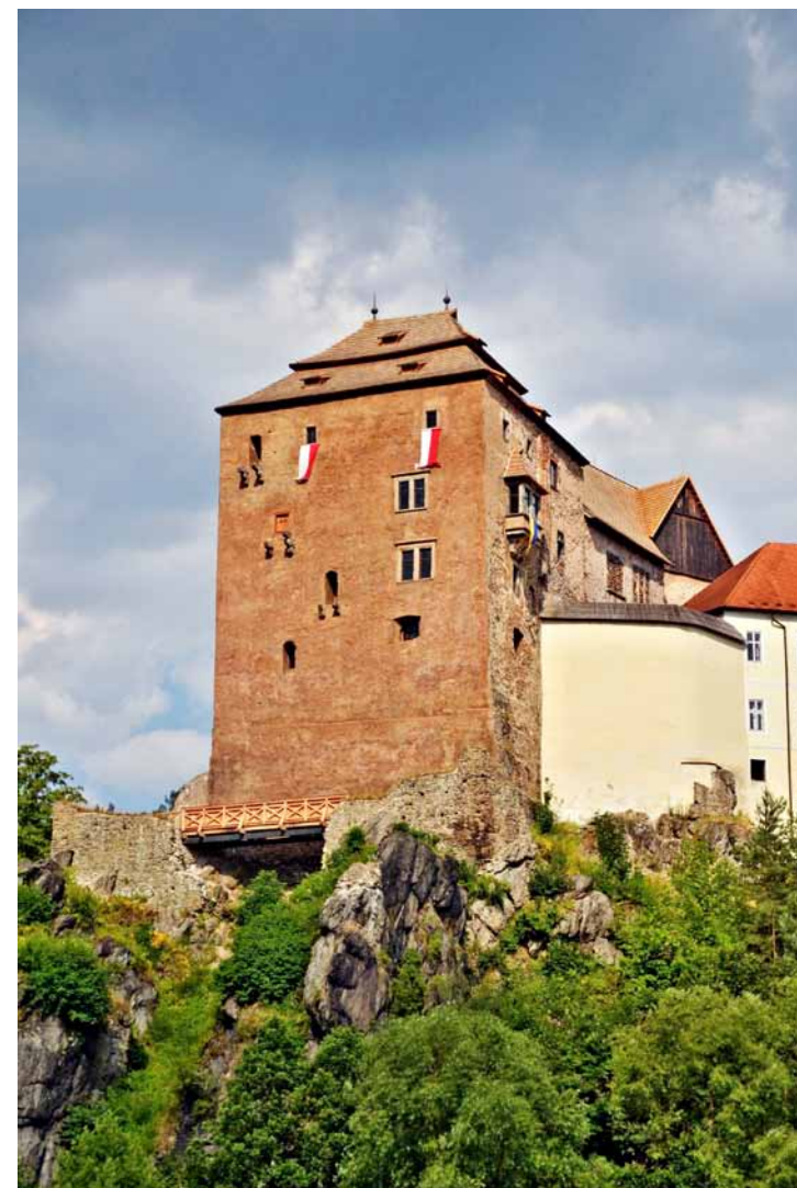
Hrad Bečov - celkový pohled na obnovenou mostní konstrukci a III etapu konzervace fasády hradu
