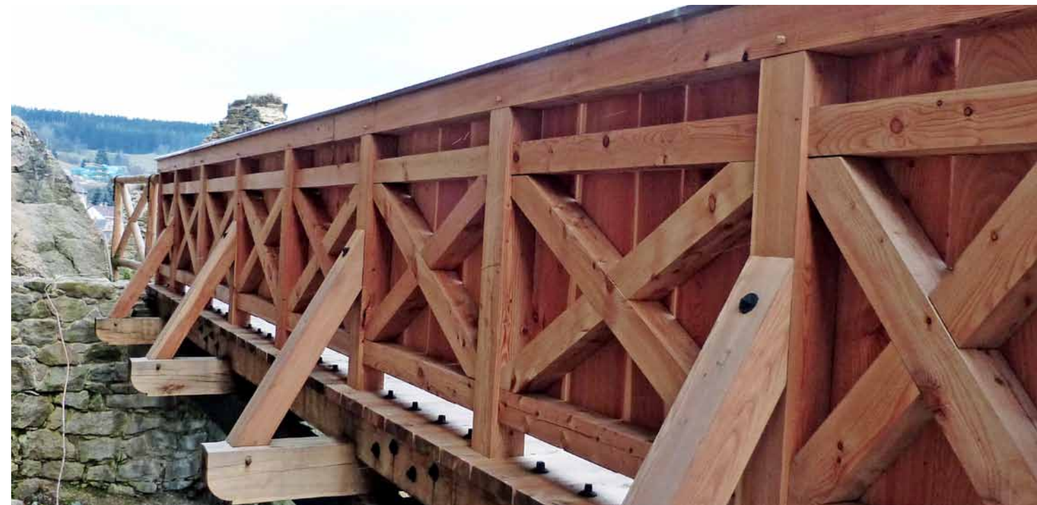
Detail provedení mostní konstrukce
