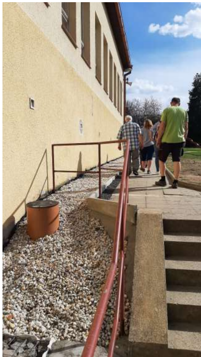
Součástí opatření se stal také tzv. lapol - odlučovač tuku pro čištění odpadní vody ze školní kuchyně
