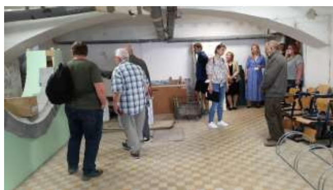
Ústup vlhkosti je patrný...
