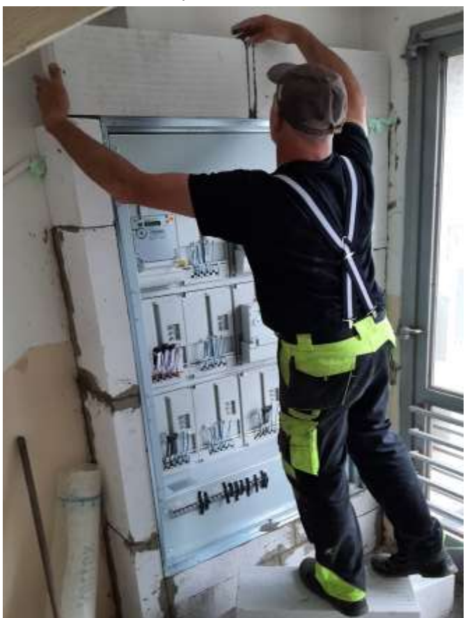
Práce na elektrickém rozvaděči
