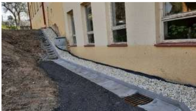
Finální podoba odvodnění skrývá v některých případech až 6 m hluboké výkopy...
