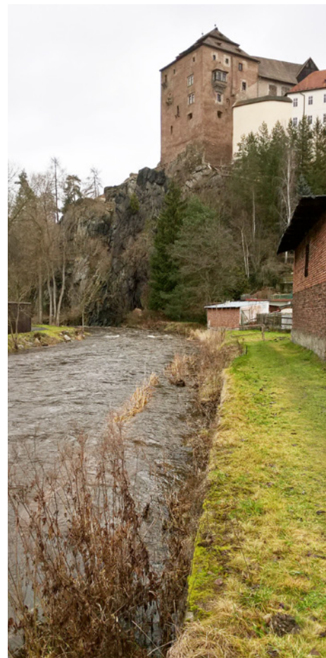
Opěrná zeď mezi lávkou a bečovským hradem bude opravena po zhotovení stavební projektové dokumentace.
