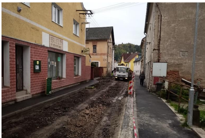
Rekonstrukce ulice Nádražní
