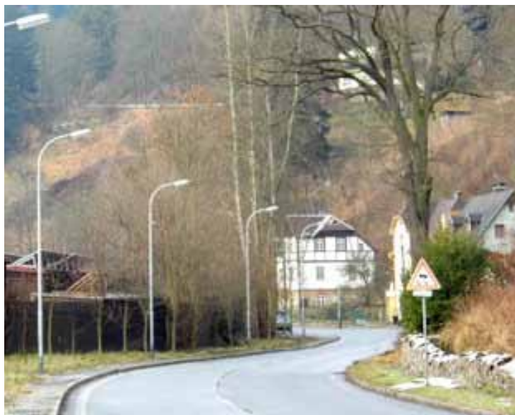
Nové osazení sloupů veřejného osvětlení v Mariánskolázeňské ulici
