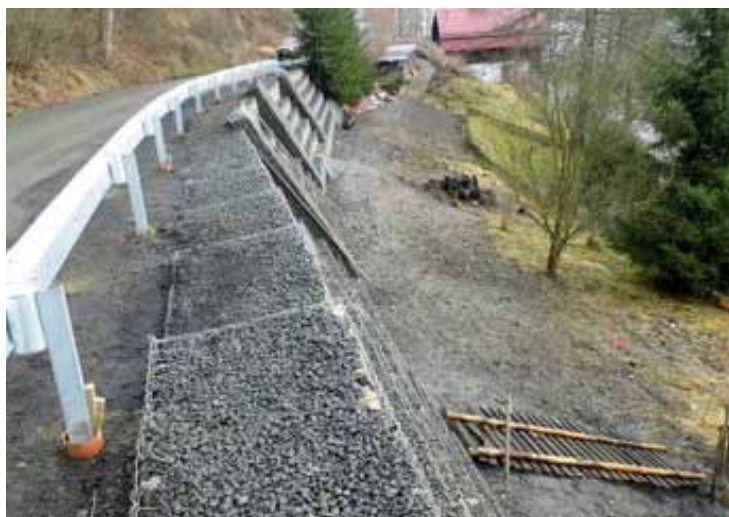
Oprava opěrné zdi a zpevnění silnice v Novoveské ulici
