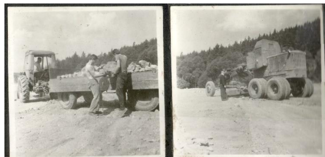
Záběry ze stavby sportovního stadionu z.r.1962.
