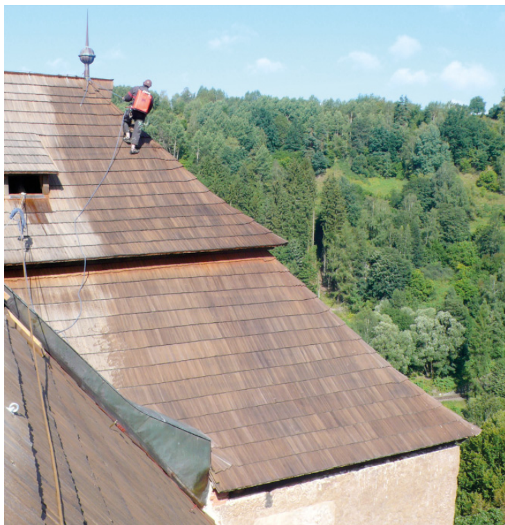
Udržovací nátěr šindelové střechy hradu
