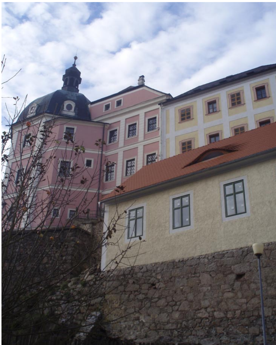
Hasičská vodní nádrž pro objekt areálu Státního hradu a zámku SHZ Bečov nad Teplou byla velmi kultivovaným způsobem umístěna do malého domku se sedlovou střechou a v těchto dnech dokončena. Bečovská národní kulturní památka je tím zajištěna proti případnému požáru.
