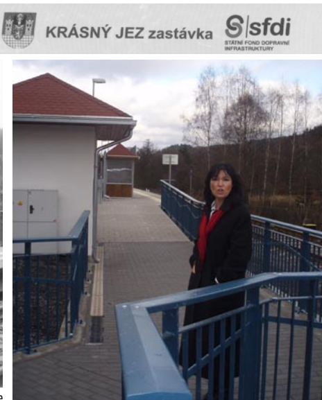
Stavba železniční zastávky Krásný Jez je dokončena.
