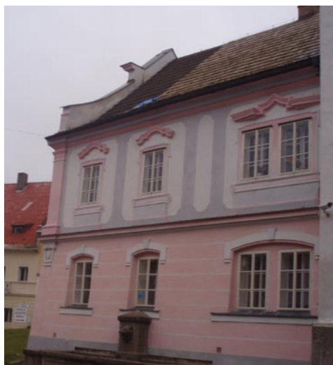
Částečná oprava střechy radnice byla pro letošní rok ukončena. Nejvíce dřevomorkou narušené nosní trámy byly nahrazeny zdravými trámy a stípaná šindel byla položena ve dvou vrstvách. V příštím roce budeme v opravě pokračovat.
